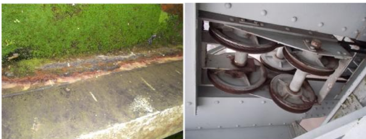
Koroze uvnitř hradidla, závěsné kladky MH
