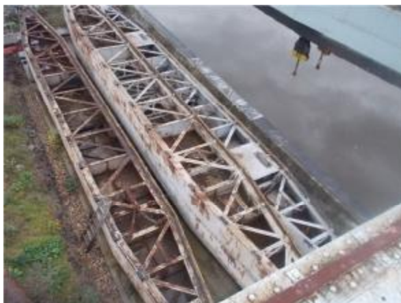
Pohled na skládku hradidel DPH - Koroze dna plováků DPH
