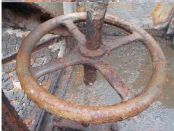
Poškození zavodňovacích ventilů – Zavodňovací klapky, vodítko
