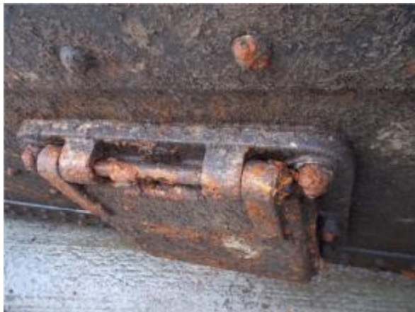
Poškození zavodňovacích ventilů – Zavodňovací klapky, vodítko
