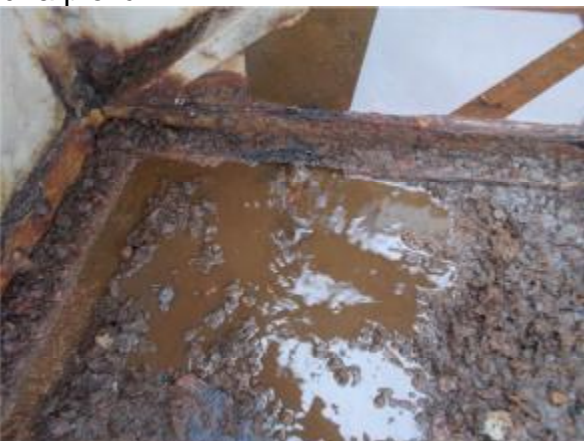
Pohled na skládku hradidel DPH - Koroze dna plováků DPH
