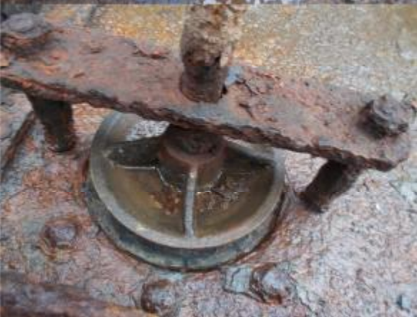
Poškození zavodňovacích ventilů – Zavodňovací klapky, vodítko
