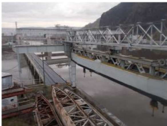
Pohled na skládku hradidel DPH - Koroze dna plováků DPH
